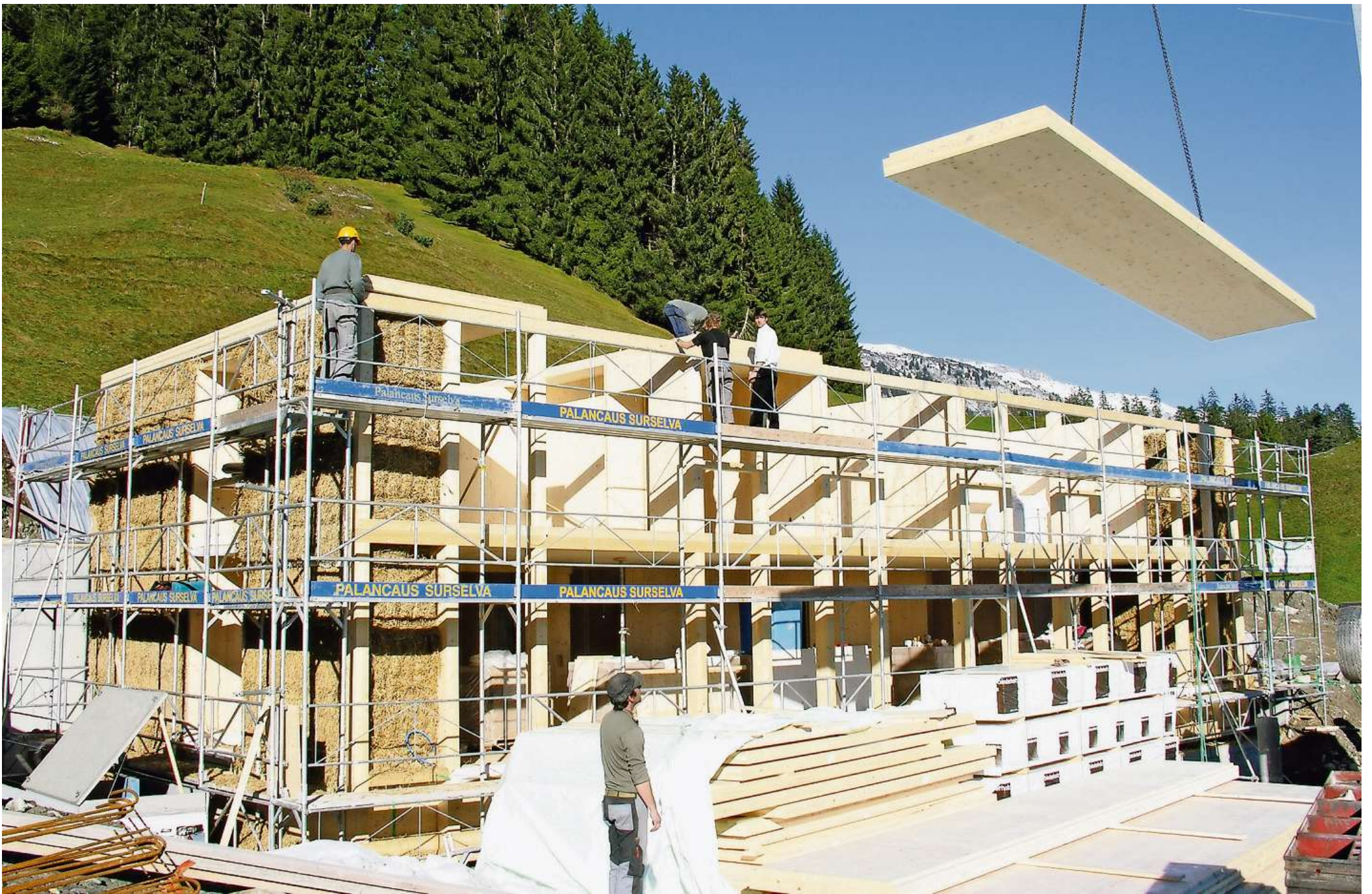
Hoch über Laax baute Werner Schmidt den Bauernhof Gliott. Die ganze Last des Hauses ruht auf Strohbällen. Nur der Dachstuhl, einige Innenwände und die Fensterrahmen sind aus Holz.
