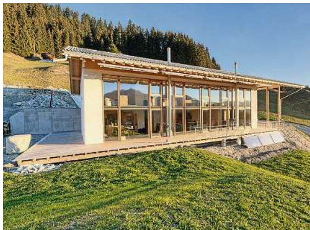
Der Galloway-Hof Gliott: Die Glasfassade dient als Heizung.
