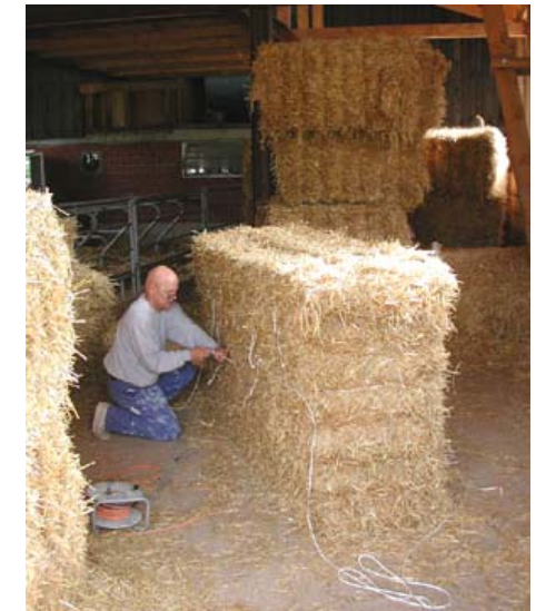
Abb. 5 Architekt verstärkt die Jumboballen
