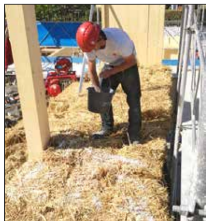
Kalk wird zwischen die Strohhallen geschüttet. Foto: zVg
